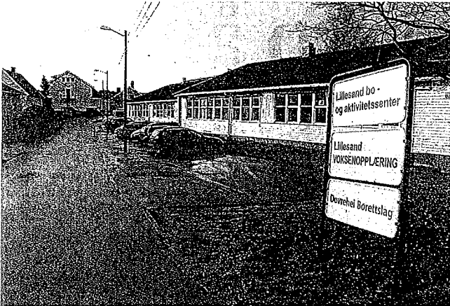
Skolebygningene på Dovre, som nå står tomme, skal rives og gi plass til et flunkende nytt helsesenter. Her skal leger, fysioterapeuter og psykiatere samles for å gi et godt omsorgstilbud til befolkningen i Lillesand. FOTO: ERLEND OLSBU
